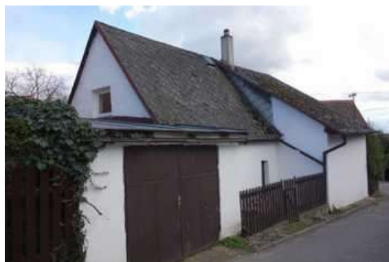
pohled od severovýchodu
