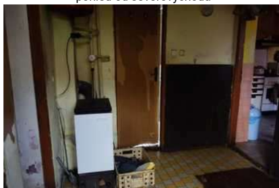
chodba s kotlem
